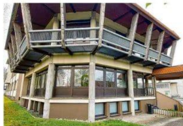
Das Steinacker-Areal war einst Firmensitz von AS-Motor. Im Verwaltungsgebäude befindet sich eine Flüchtlingsunterkunft. Foto: Axel Theurer
